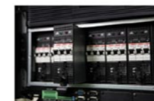
Дополнительный модуль распределения электропитания (RPDC) стоечного монтажа с модулями управления и модулями коммутационных аппаратов, поддерживающими горячую замену
